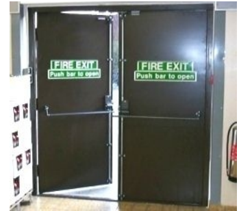
รูปที่ 5.11 ประตูหนีไฟ
