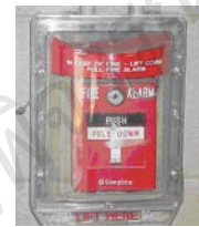
รูปที่ 5.4 อุปกรณ์แจ้งเหตุเพลิงไหม้
