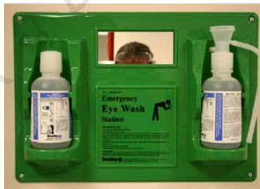
รูปที่ 5.2 ตัวอย่างป้ายบอกบริเวณที่ล้างตา ชุดล้างตาแบบติดผนัง และที่ล้างตา
